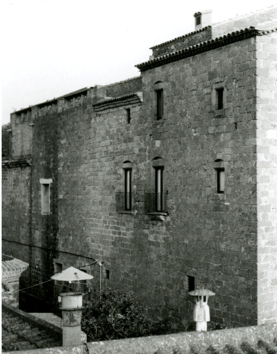
Fig. 13: Façana nord de l'església del convent en que s'aprecien els trams de motllures a tocar de la teulada (foto AMPuig, any 1987)
