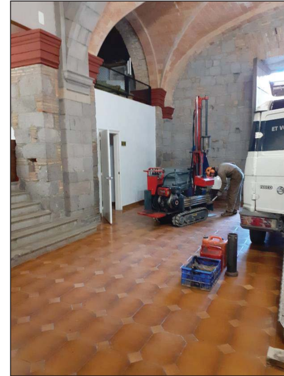
Foto 1. Execució Penetròmetre P-1.
