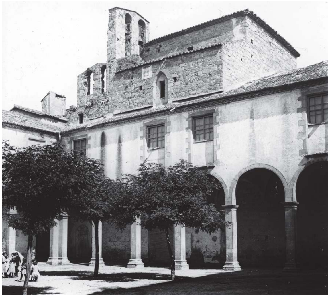
Fig. 14: Imatge de Francesc Xavier Parés i Bartra, datada entorn de l'any 1915, en la que es veu la part elevada que corresponia a la coberta de la cúpula del transsepte, i les restes dels dos campanars d'espadanya, el més gran dels quals avui està perdut (col·lecció Manel Puig; Puig 2017, 114)
