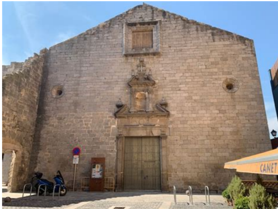
Imatge 1: Vista de la façana de l'accés principal de l'edifici
